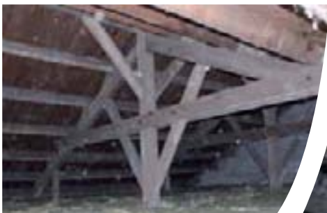
Charpente en combles perdus
