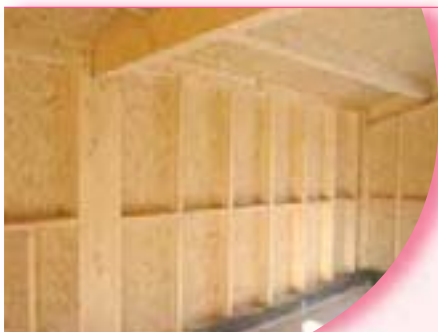
Murs à ossature bois
