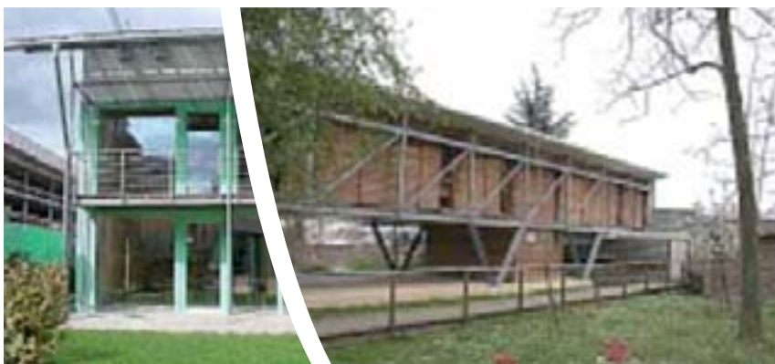
Construction sur poteaux béton
