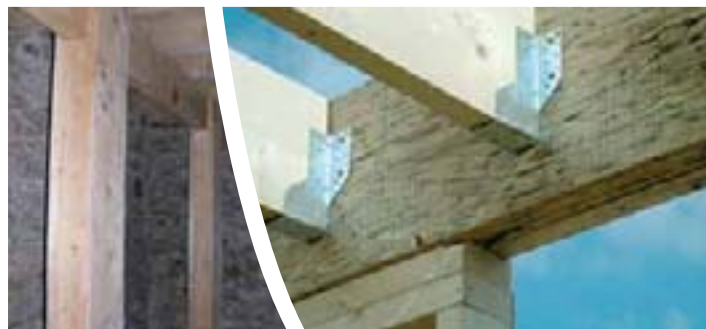
Poteaux dans volume ouvert et solives non encastrées
