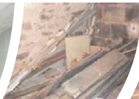
Exemple d'encombrement dans une cave
